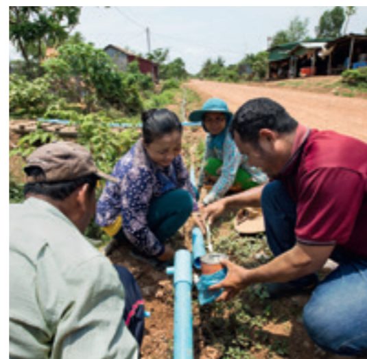
Der Ausbau von Wasserleitungssystemen in Kambodscha kommt gut voran. Dank fünf neuer Bohrlöcher und dem Einsatz von Wassertürmen können wir in Zukunft noch mehr Dörfer mit fließendem Wasser versorgen.
